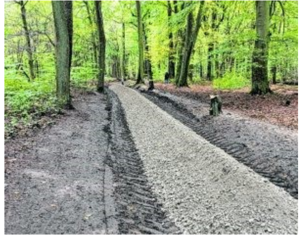
In zwei Schichten mit unterschiedlichen Körnungen wird der Natursteinschotter aufgetragen Foto: kh
